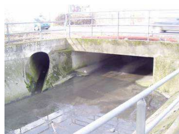
Ouvrage de rétablissement de cette rue Source : EGIS aménagement
