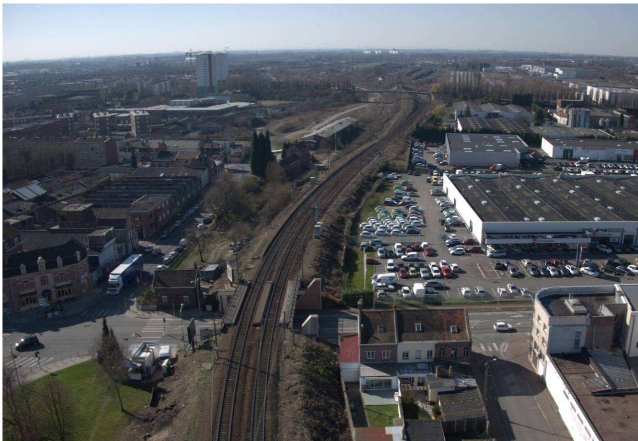
Lomme - Lambersart, carrefour de l'avenue de Dunkerque et Pont Supérieur Source : A Com Image, février 2011
