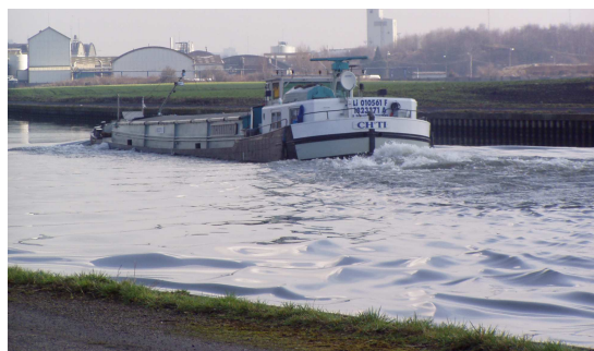
Palplanches en arrière plan de la péniche Source : EGIS aménagement
